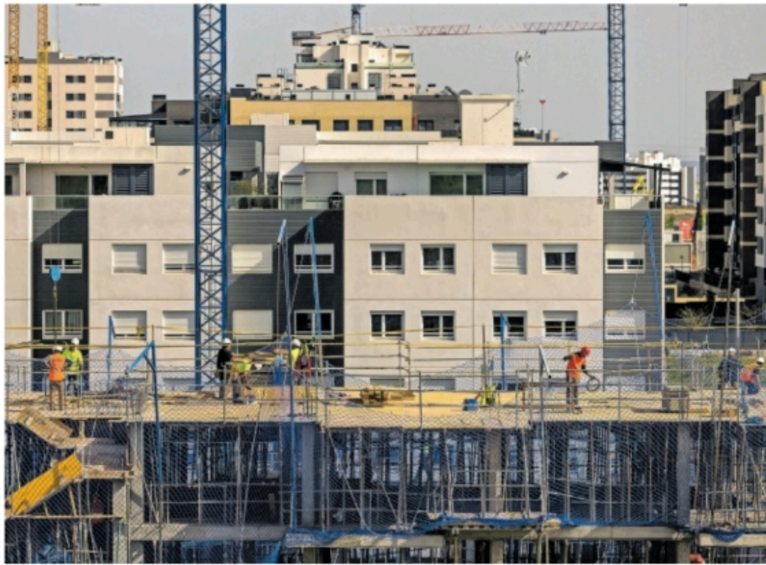
Operarios en una promoción de viviendas en obras en Madrid, en marzo. SAMUEL SÁNCHEZ
