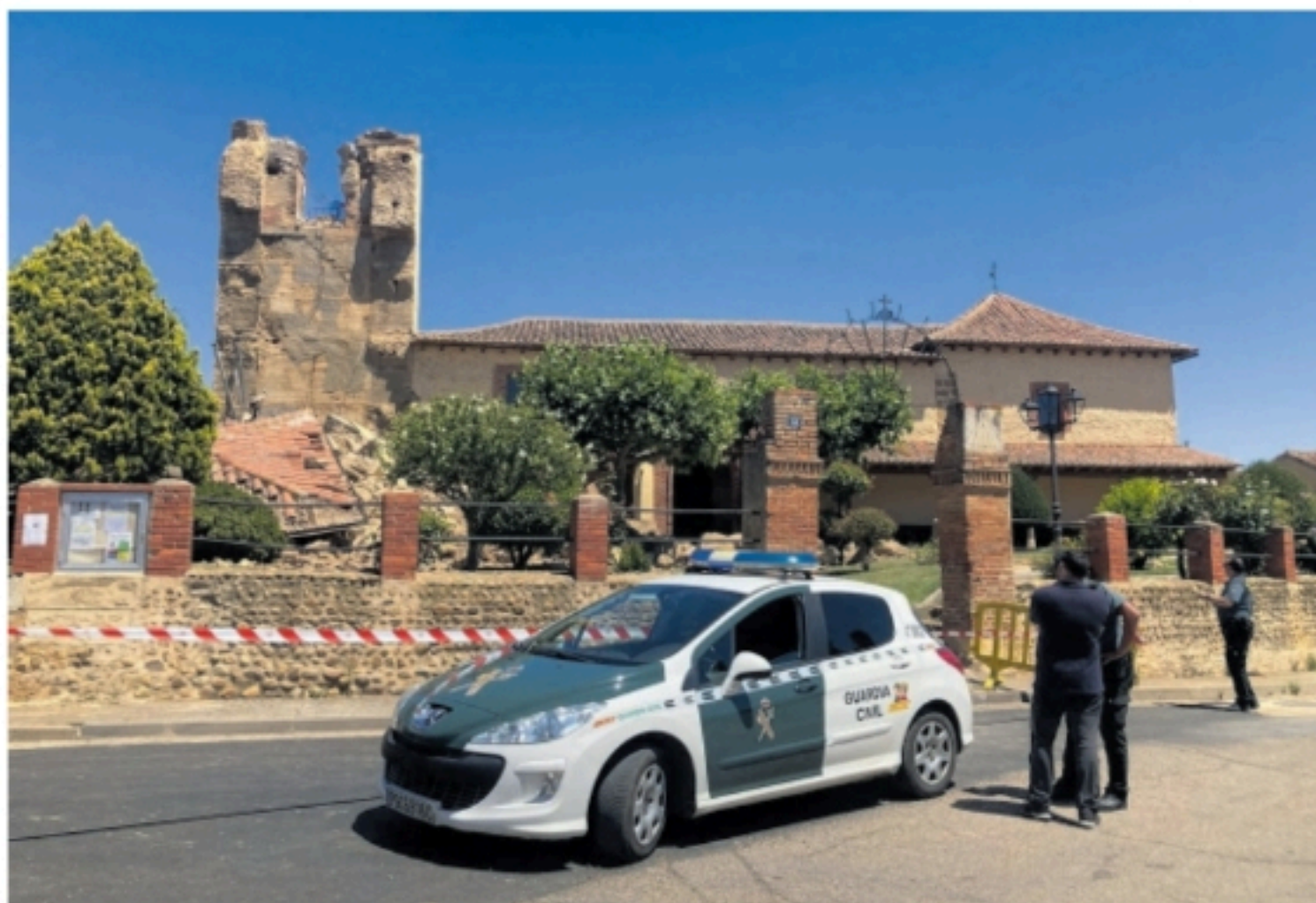
La iglesia de Villaturiel (León) con su torre derrumbada, en julio. J. CASARES (EFE)
